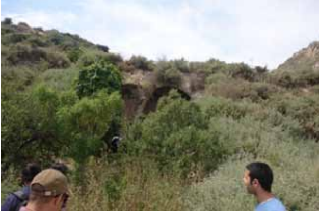
Liman alanındaki sarnıç yapısı, Sivriada, 7 Temmuz 2013
