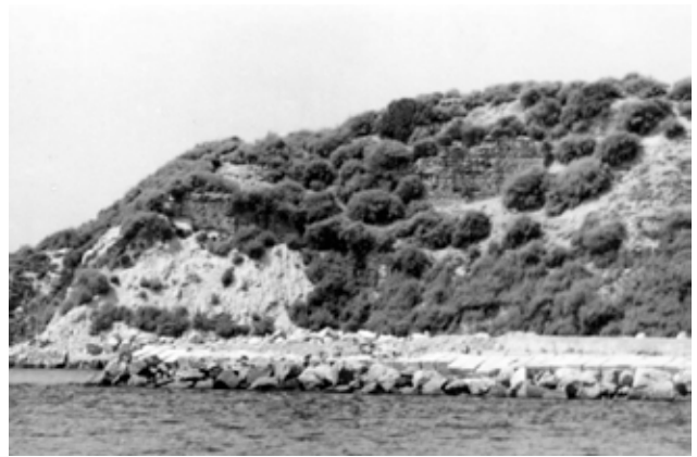
İstinat duvarları, Sivriada, İAM, Dosya No:93666
