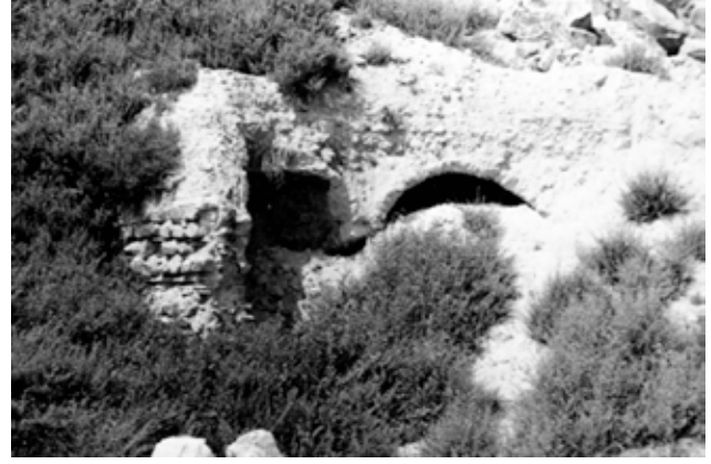
Liman alanındaki sarnıç yapısı, Sivriada, İAM, Dosya No:93666
