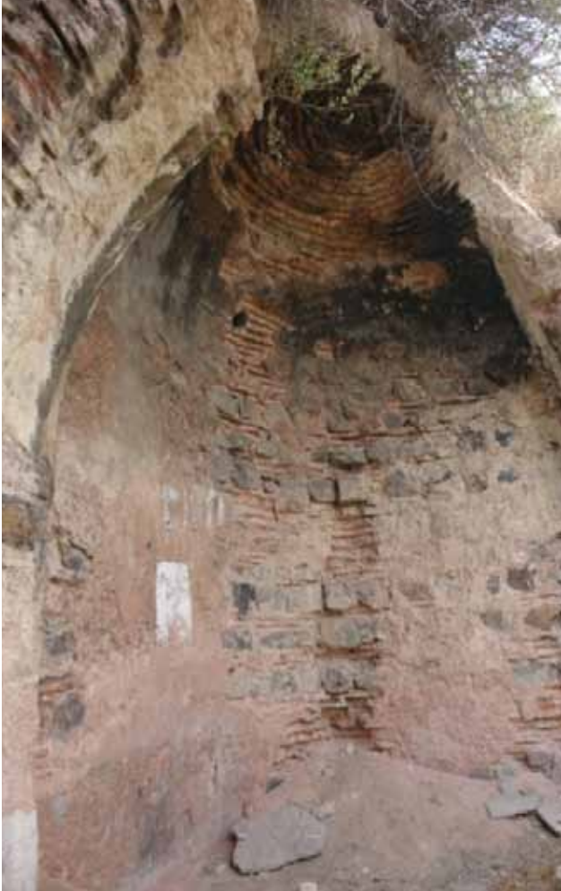
Liman alanındaki sarnıç yapısı, Sivriada, 7 Temmuz 2013
